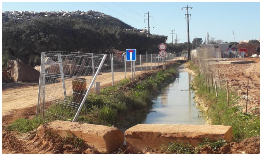
Foto 1 - Vala de drenagem paralela ao caminho
